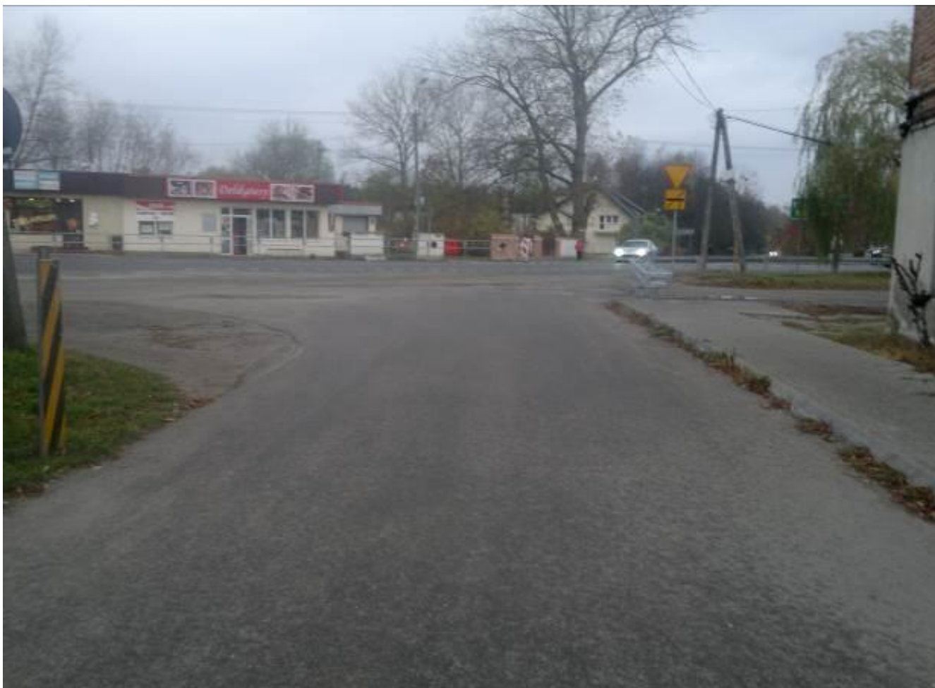
DK 79 Baniocha - przed Niezczytelne skrzyżowanie / błędna geometria wlotów
