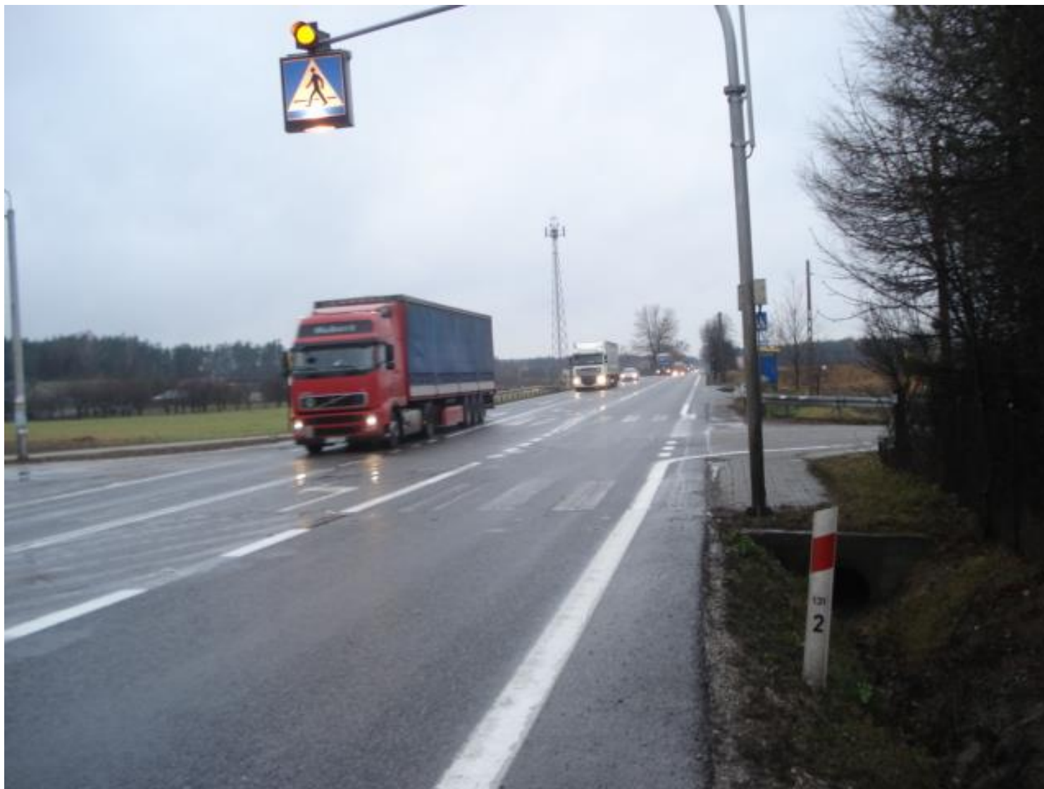
DK 50 Chudolipie (oznakowanie przejścia dla pieszych)
