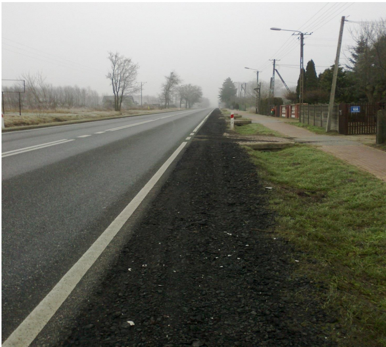
DK 62 Pomiechówek (utwardzenie poboczy)
