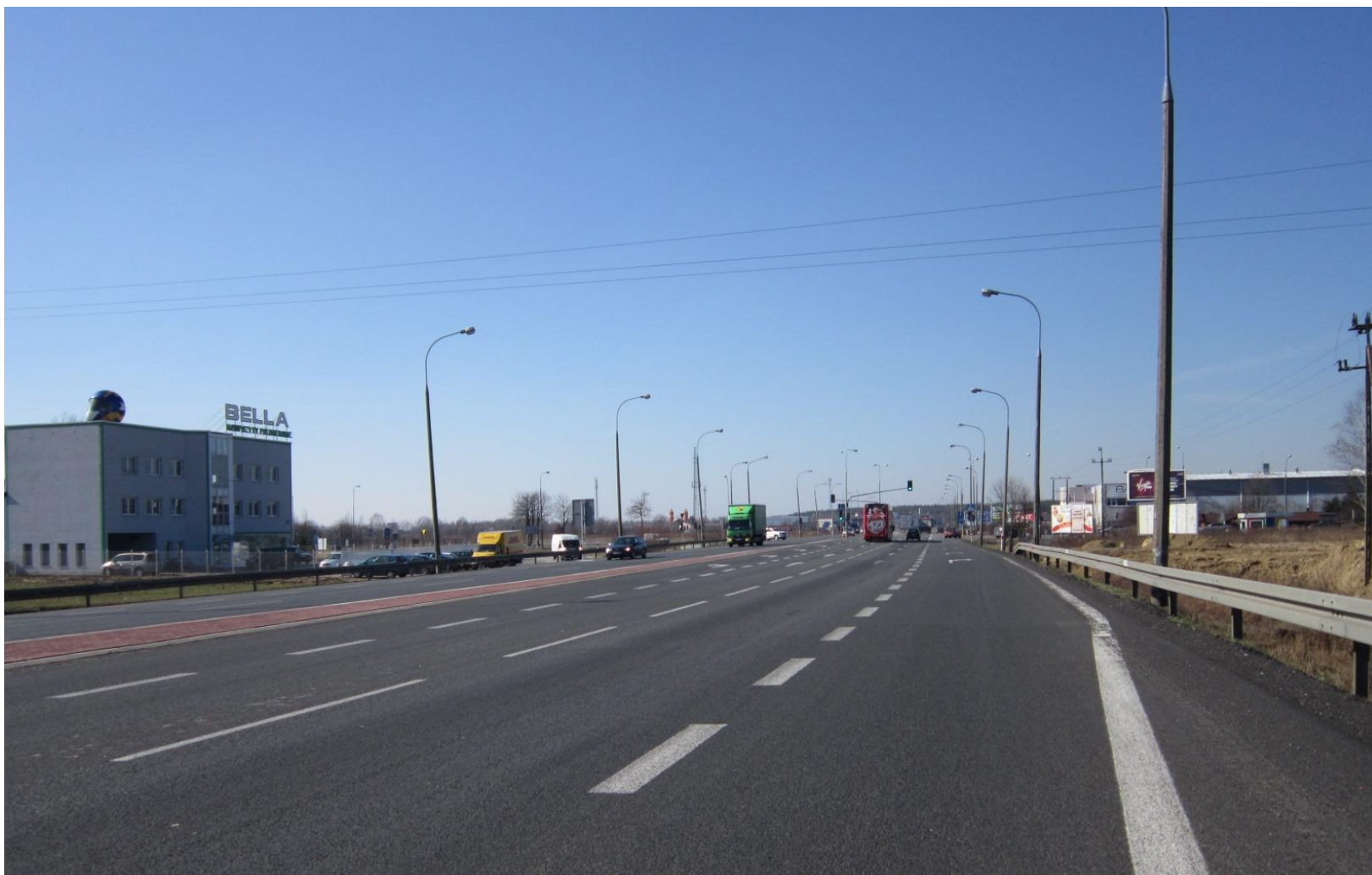
S 7 Czosnów (remont nawierzchni)
